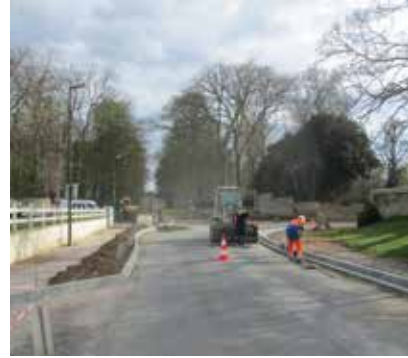
Dernière phase des travaux
