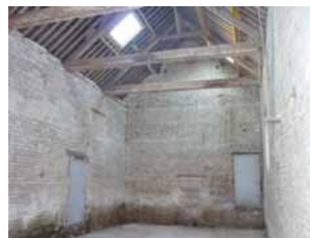
Salle d'exposition avant travaux
