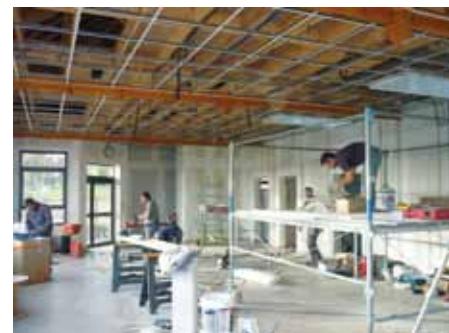
Aménagement intérieur du restaurant scolaire
