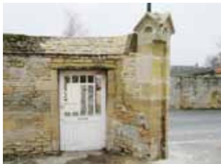
À l'entrée de cette cour, l'un des deux piliers du portail était en mauvais état ; il a donc fallu le démonter partiellement, faire tailler deux grosses pierres sur mesure par une entreprise spécialisée et procéder au remontage de toutes les pierres par deux
